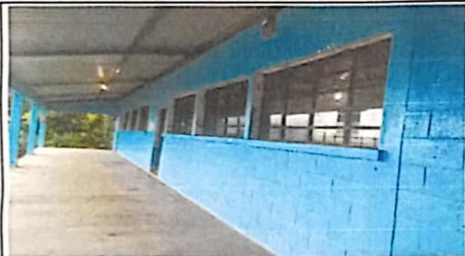
Foto 3: Se instalo ventanas con valcones resistentes de metal y vidrios.
